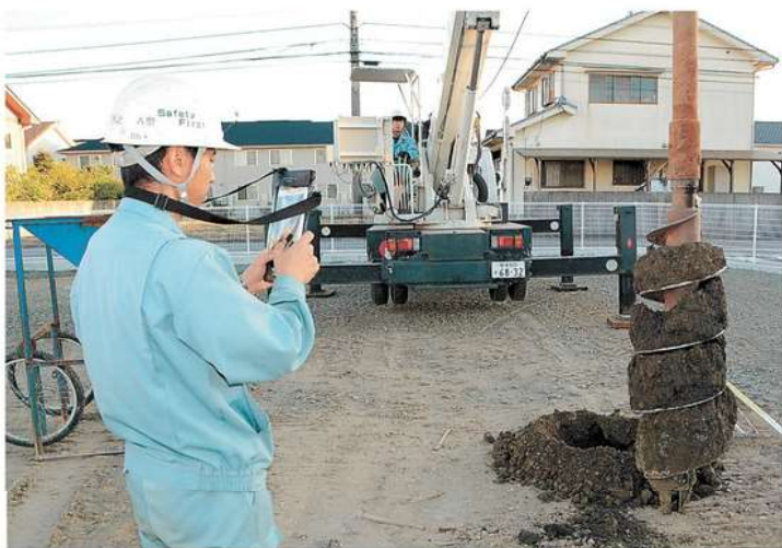
施工報告書支援アプリを搭載したタブレット端末を使う建設会社の担当者＝10月30日午後、松山市久万ノ台
