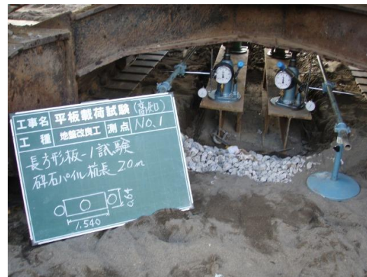
(平板載荷試験状況)
