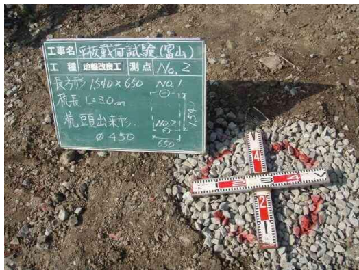
(砕石パイル試験前)
