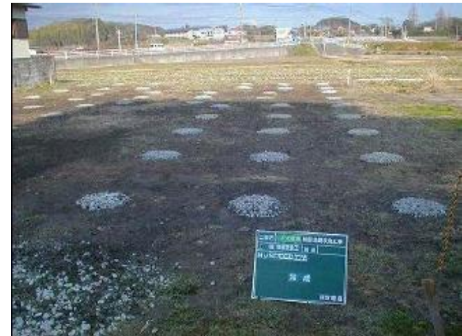
(施工完了写真)
